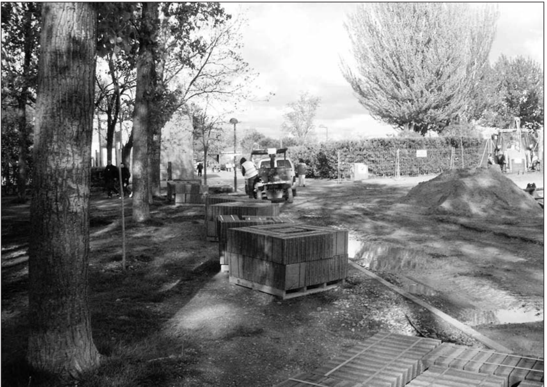
Obras del emisario en el parque
