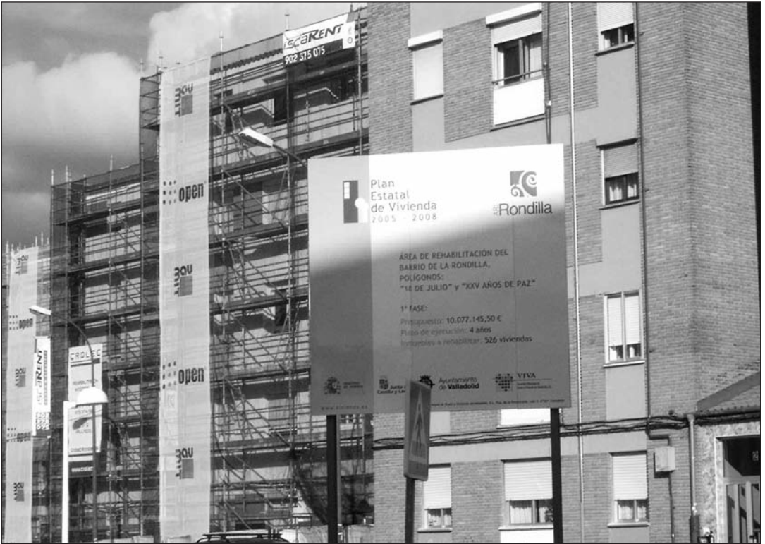
Obras del ARI en Rondilla
